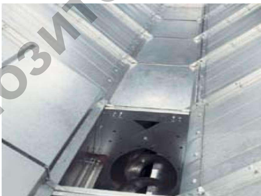
Рис. 3.75. Люк прочистки камеры-сборника с уплотнением
