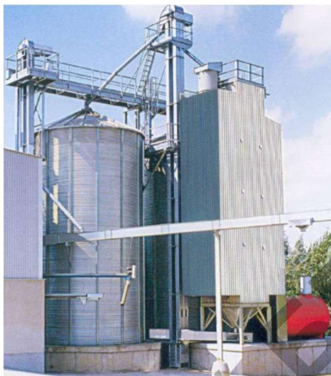
Рис. 3.24. Общий вид сушильной установки производительностью 20 т/ч, понижение влажности от 19 до 15 %
