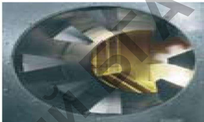
Рис. 3.73. Смотровое окно для контроля работы горелки
