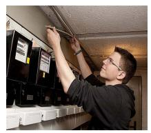
Als Nächstes sollen wir im Keller Kabelkanäle verlegen. Ich schaue mir zuerst an, wie die Wand beschaffen ist. Davon hängt es ab, ob wir normale Dübel brauchen oder spezielle. Dann zeichnen wir die Reihenfolge für die Dübel auf der Wand so ein, dass die Kabelkanäle am Ende gerade
