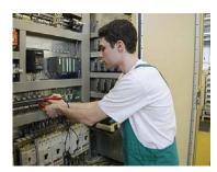
Die Maschinen arbeiten mit einer elektrischen Spannung von 400 Volt, darum arbeite ich konzentriert und sehr vorsichtig. Ich messe mit einem Prüfgerät die an den Bauteilen anliegenden Spannungen. Dann führe ich eine Sichtkontrolle durch: Ich schaue z.B., ob Bauteile angeschmort sind. Die Anlage läuft einwandfrei, es sind keine Mängel festzustellen. Damit habe ich alle Aufgaben erledigt. Ich ziehe mich um und mache mich auf den Heimweg.
