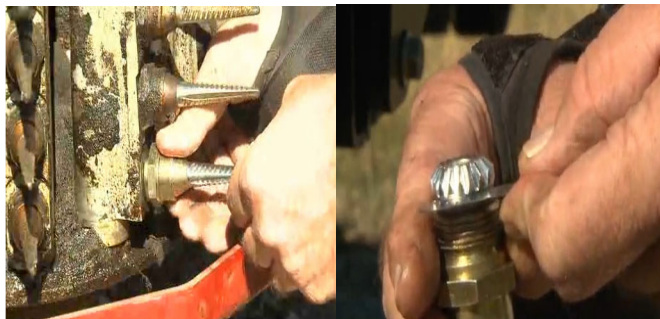
Рисунок 4 – Проверка состояния шпинделя и его втулки
