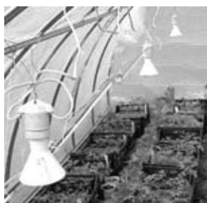
Рис. 1 – Освещение теплицы лампами ДРТ-375
