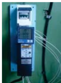
Рис. 2 – Векторный преобразователь частоты с анализатором качества электроэнергии
