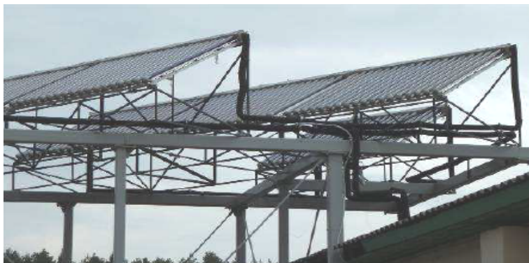
Рисунок 1 – Система подогрева питьевой воды для животных в Агрофирме «Унибокс»
