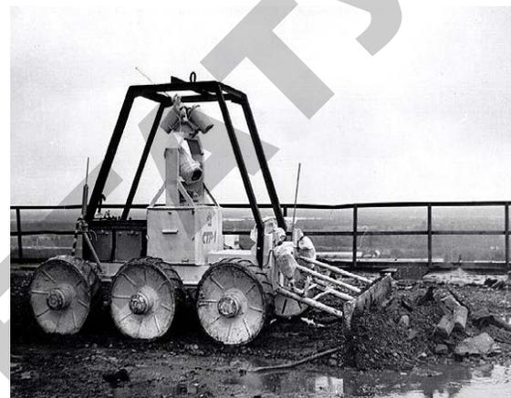
Рис. 46. Специализированный транспортный робот СТР-1. Проработал в общей сложности около 10 ч и очистил около 20 кв. м крыши
