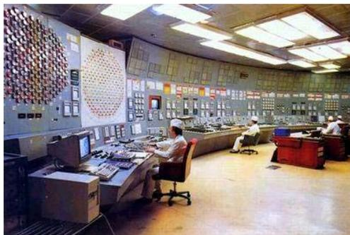
Рис. 40. Щит управления блоком с реактором РБМК
