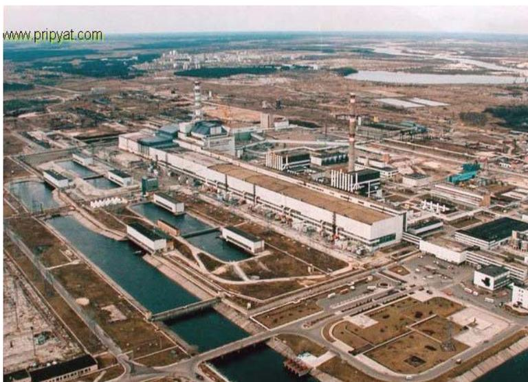
Рис. 34. Чернобыльская АЭС (вдали – город Припять) Длинное (около 1 км) здание перед блоками – турбинный зал, общий для всей АЭС
