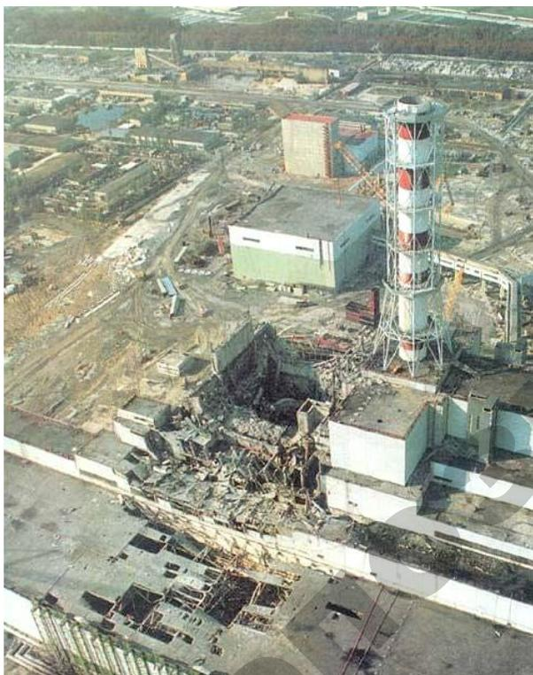
Рис. 42. 3-й и 4-й блоки после взрыва
