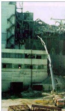
Рис. 53. Дистанционная подача бетона
