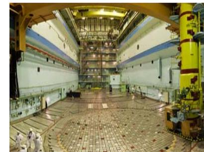
Рис. 37. Центральный зал реактора. Вид на плитный настил и разгрузочно-загрузочную машину
