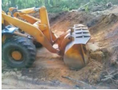
Рис. 1 – Разработка бокового резерва фронтальным погрузчиком
