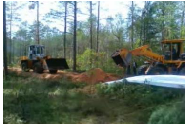
Рис. 2 – Транспортировка грунта на полотно дороги
