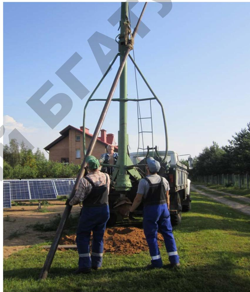
Рис. 4.5. Установка экспериментального образца молниеотвода с максимально регламентируемым уровнем молниезащиты (площадка в д. Боровляны Минского района)
