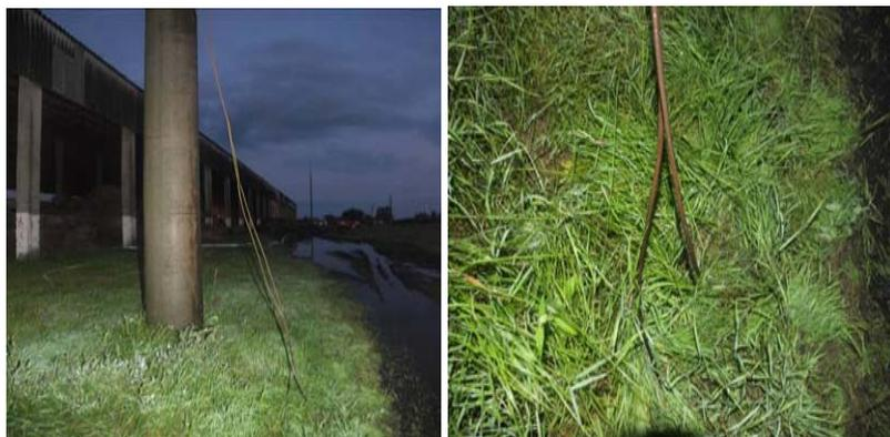
Рис. 1.14. Внешний вид неисправных молниеотводов на сырьевом складе Березинского филиала ОАО «Воложинский льнокомбинат»
