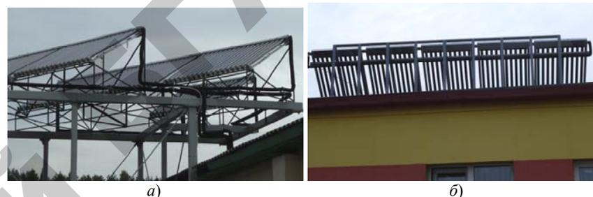
Рис. 7.11. Расположение вакуумных солнечных коллекторов на крышах ферм КРС (система подогрева питьевой воды для животных):
