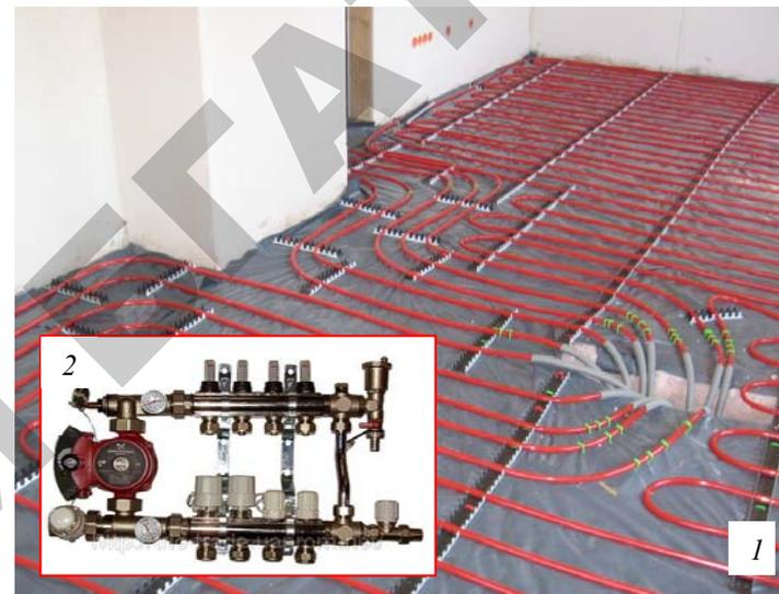
Рис. 3.14. Система отопления на базе обогреваемого водяного пола:
