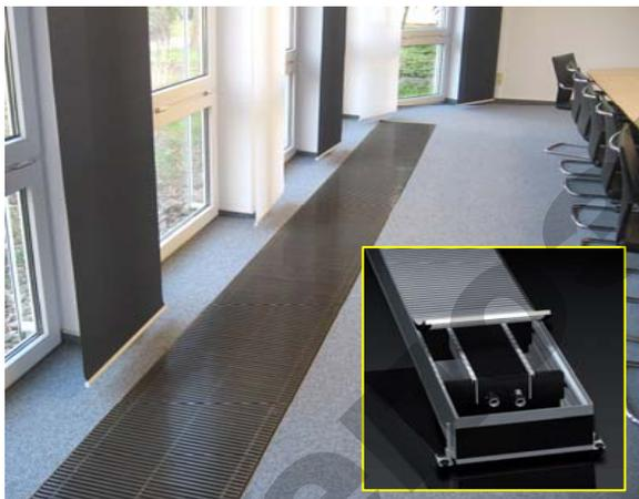
Рис. 3.15. Встраиваемые в пол конвекторы с естественной конвекцией типа WSK
