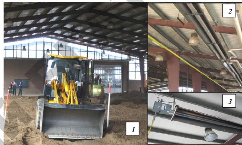
Рис. 3.12. Использование газовых инфракрасных нагревателей в крытых павильонах:
