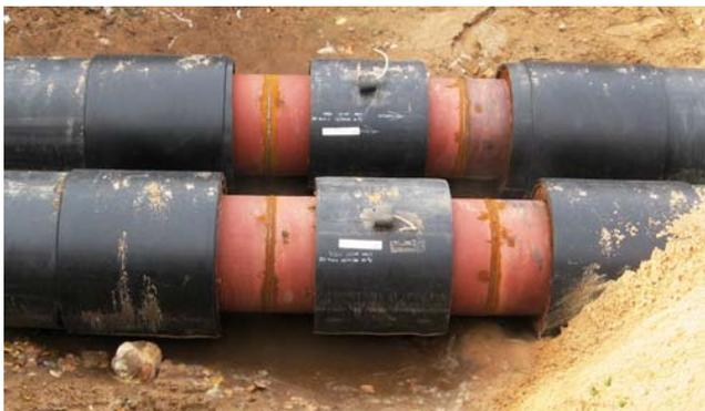
Рис. 5.2 Расположение ПИ-труб в канале (без соединительных муфт)
