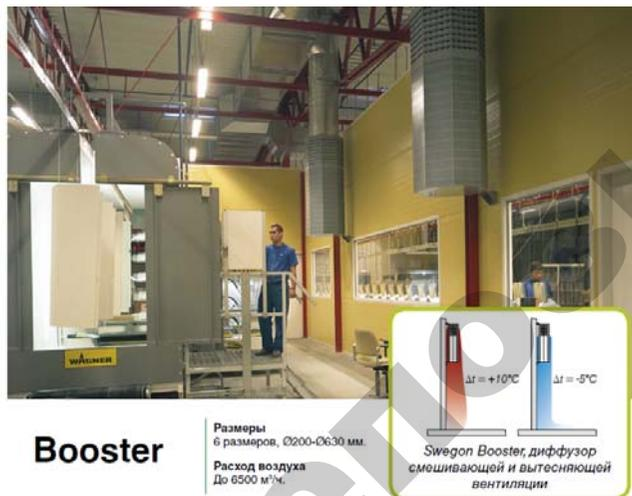
Рис. 4.22. Размещение диффузоров приточного воздуха на молокозаводе
