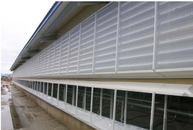
Рис. 4.9. Использование специальных мембран вместо обычных штор в помещениях содержания КРС
