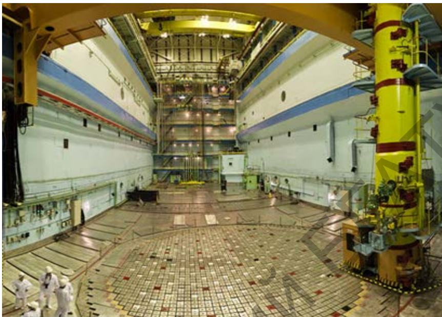
Рис.37. Центральный зал реактора. Вид на плитный настил и разгрузочно-загрузочную машину
