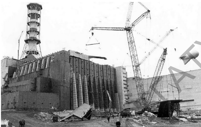
Рис. 54. Строительство саркофага
