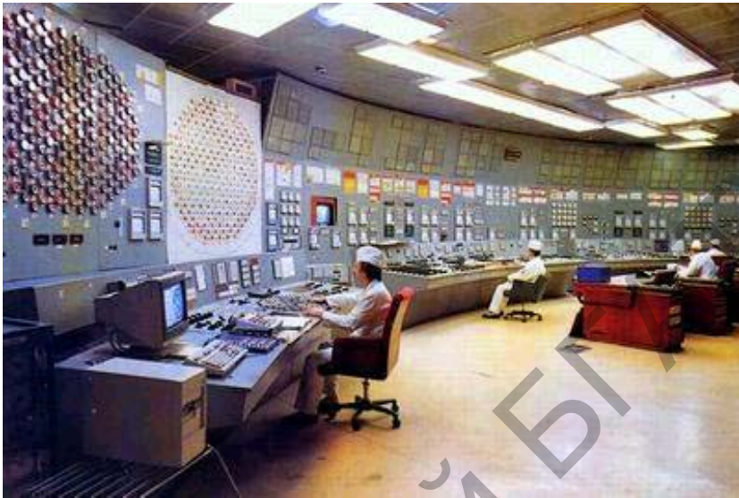
Рис. 40. Щит управления блоком с реактором РБМК
