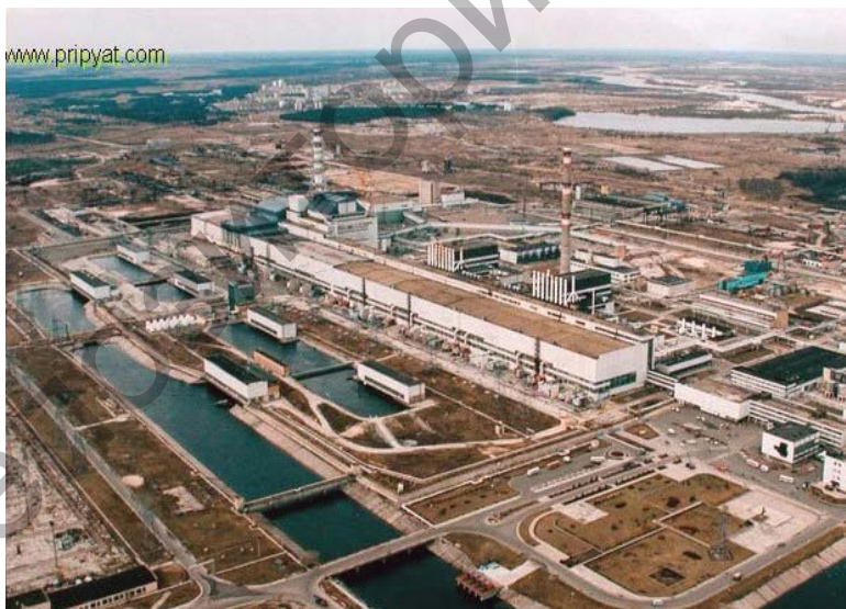
Рис. 34. Чернобыльская АЭС (вдали – город Припять) Длинное (около 1 км) здание перед блоками – турбинный зал, общий для всей АЭС
