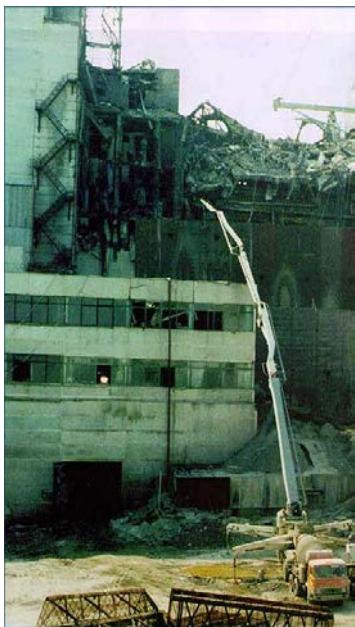
Рис.53 Дистанционная подача бетона
