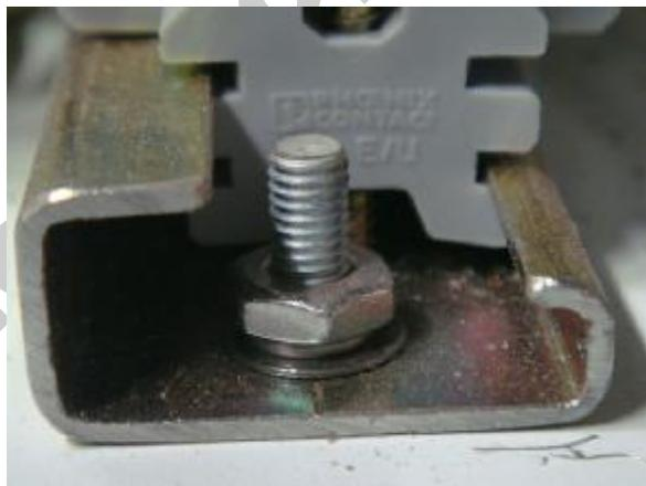
Рис. 32. Крепление DIN-рейки G-типа
