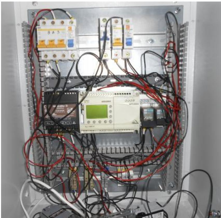
Рис. 27. Шкаф НКУ с установленным электрооборудованием
