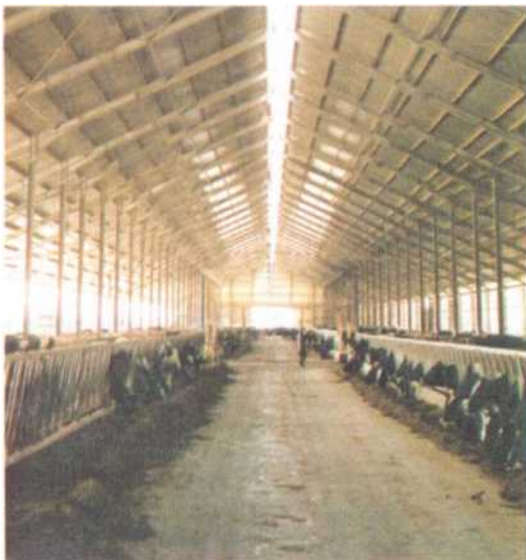
Рис. 77. Коровник с коньковой вентиляцией
