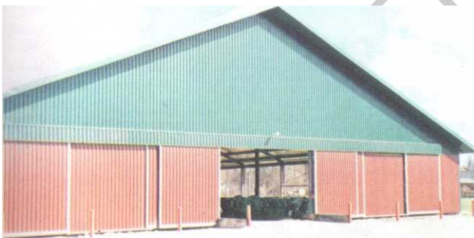
Рис. 74. Внешний вид коровника с трансформирующимися стенами
