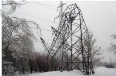
Рис. 2. Разрушенная опора ВЛ под воздействием гололёда.
