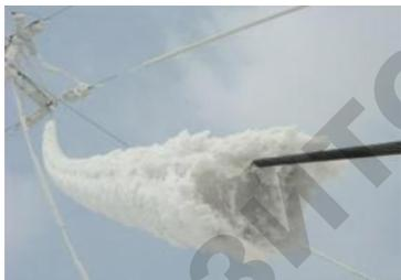
Рис. 1. Образовавшийся гололёд на проводах ВЛ
