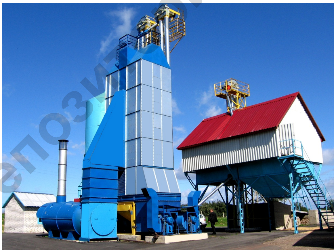
Рис. 3.1. Общий вид зерноочистительно-сушильного комплекса ЗСК-20
