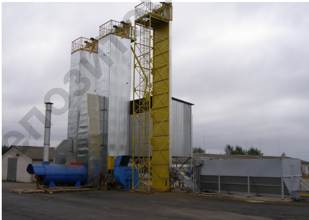
Рис. 1.1. Общий вид зерноочистительно-сушильного комплекса ЗСК-15
