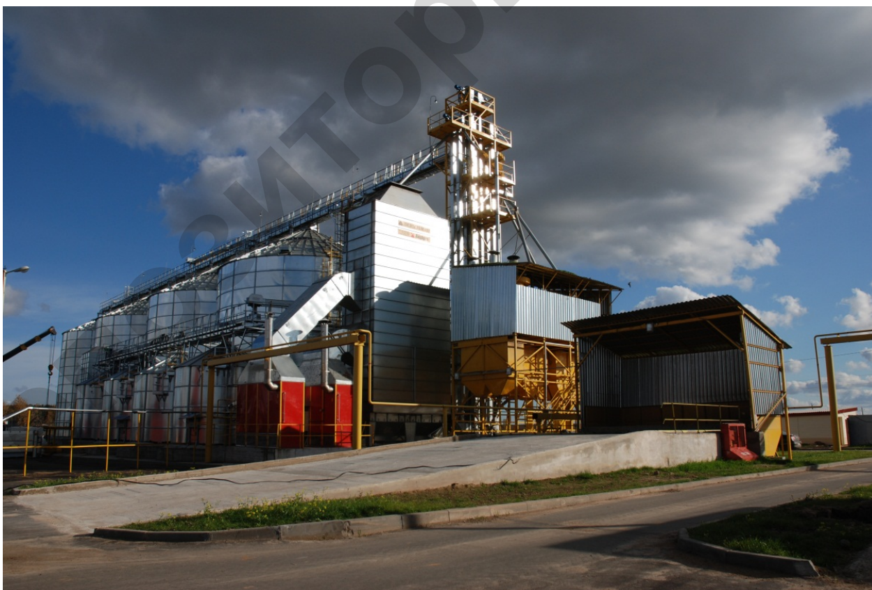
Рис. 4.1. Общий вид зерноочистительно-сушильного комплекса КЗСВ-30
