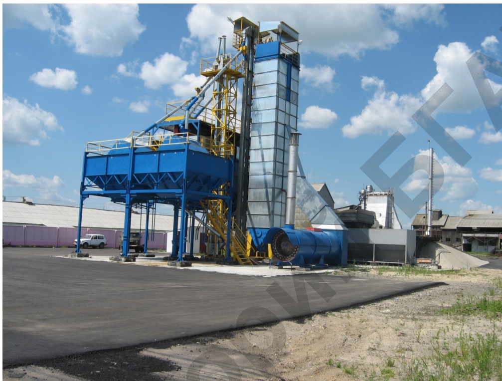
Рис. 3.3. Общий вид зерноочистительно-сушильного комплекса ЗСК-30
