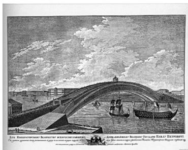
Рисунок 5 – Внешний вид деревянного арочного моста Кулибина по проекту 1777 г. (по «Рукописным материалам. И.П. Кулибина»)
