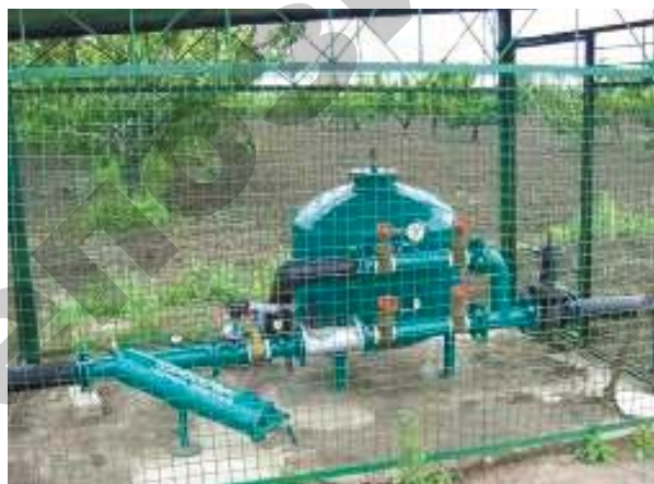
Рисунок 3. Песчано-гравийные фильтры различной конструкции
