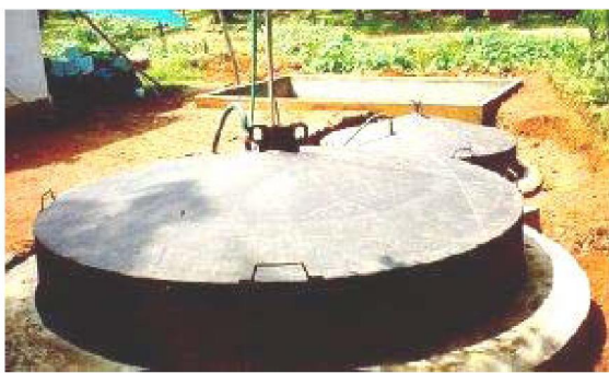
Рис.23. Простейшая биогазовая установка (Тайвань)
