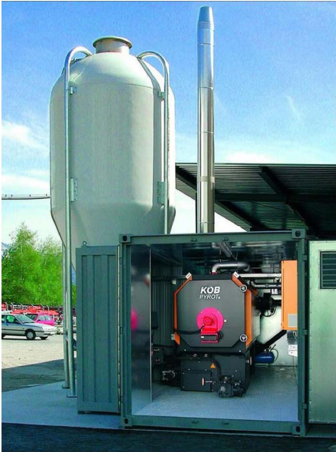
Рис. П 3.11. Теплоэнергетическая установка мощностью 300 кВт фирмы КОВ (Австрия), использующая в качестве топлива пеллеты
