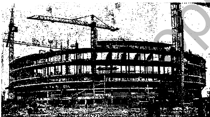
Рисунок 2 — Каркас строящегося спортивно-зрелищного комплекса
