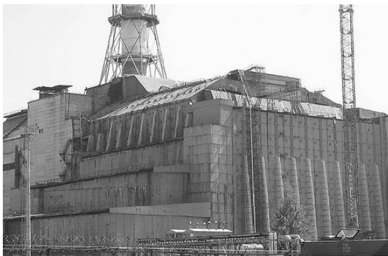
Рис. 5.29. Укрытие «саркофаг» над четвёртым энергоблоком ЧАЭС
