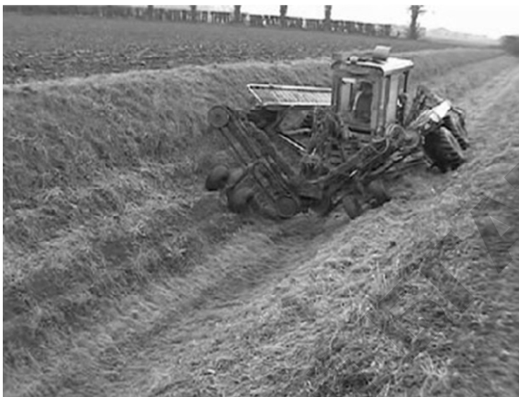
Рис. 5.24. Окашивание откосов канала
