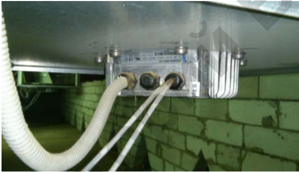
Рис. 2 – Интеллектуальная система встроена в ЕС вентилятор, что ведёт к не ремонтпригодности вентиляторов
