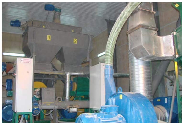
Рисунок 2 – Общий вид применяемого оборудования линии
