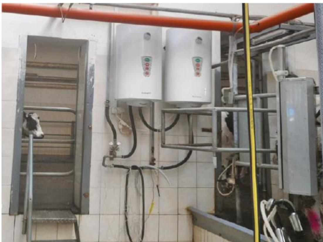
**Рисунок 2.88 – Водонагреватели линии ухода за животными**
