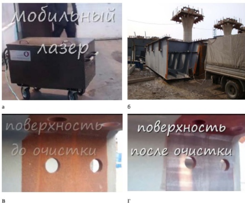
Рисунок 6.7 - Лазерная очистка стыков от ржавчины ферм моста а – мобильный лазер, б – ферма моста, в – поверхность до очистки, г – поверхность после очистки
