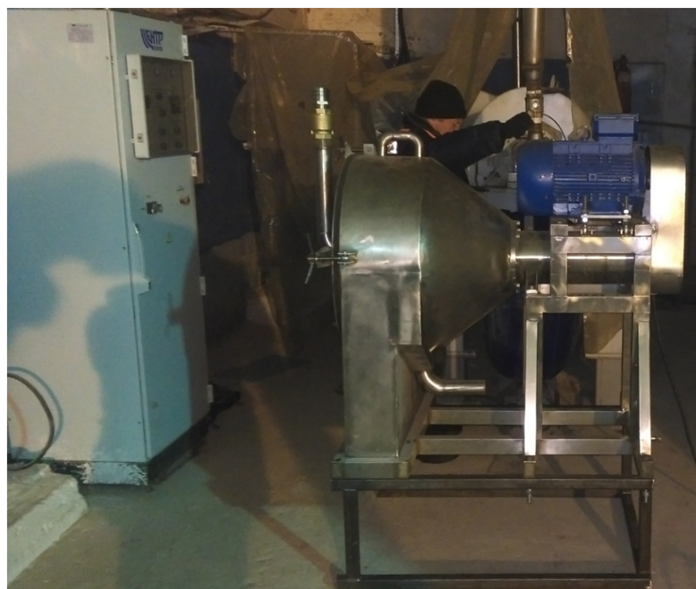
Рис. 3. Монтаж сита центробежного Ш12-УЦМ
