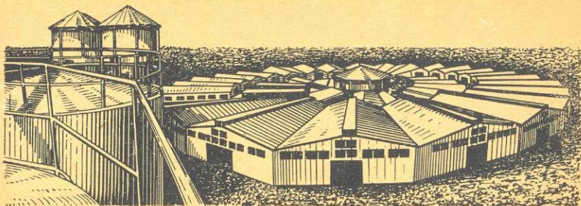
РИС. 15. Общий вид фермы на 1200 голов крупного рогатого скота с радиальным размещением зданий.
