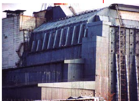
Вид IV блока ЧАЭС после строительства саркофага
