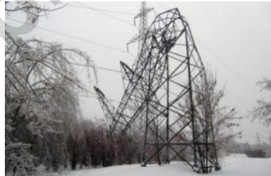
Рис. 2. Разрушенная опора ВЛ под воздействием гололёда.
