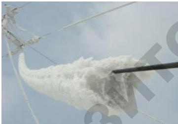
Рис. 1. Образовавшийся гололёд на проводах ВЛ
