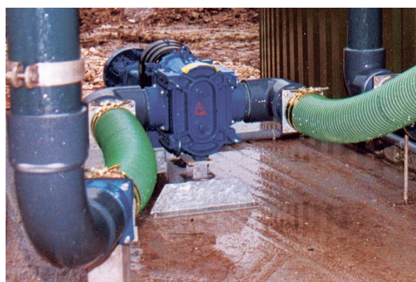
Рис. 5. Трубопровод для транспортировки навоза
