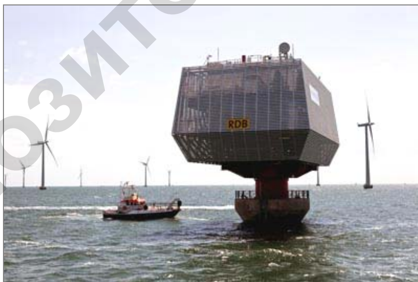
Рис. 5.6. Трансформаторы весом 990 т тоже устанавливаются в море
