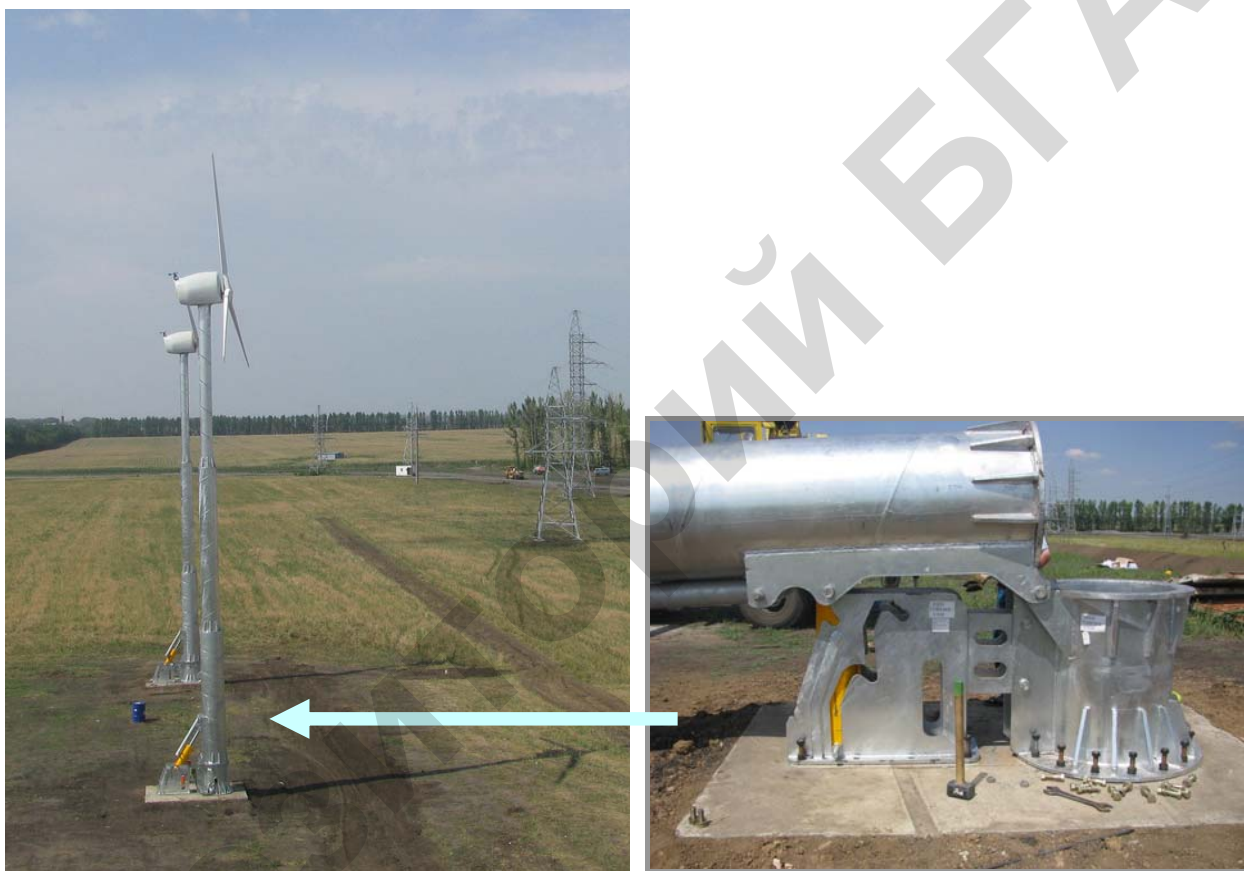
Рис. 6.2. Монтаж ВЭУ мощностью 20 кВт
