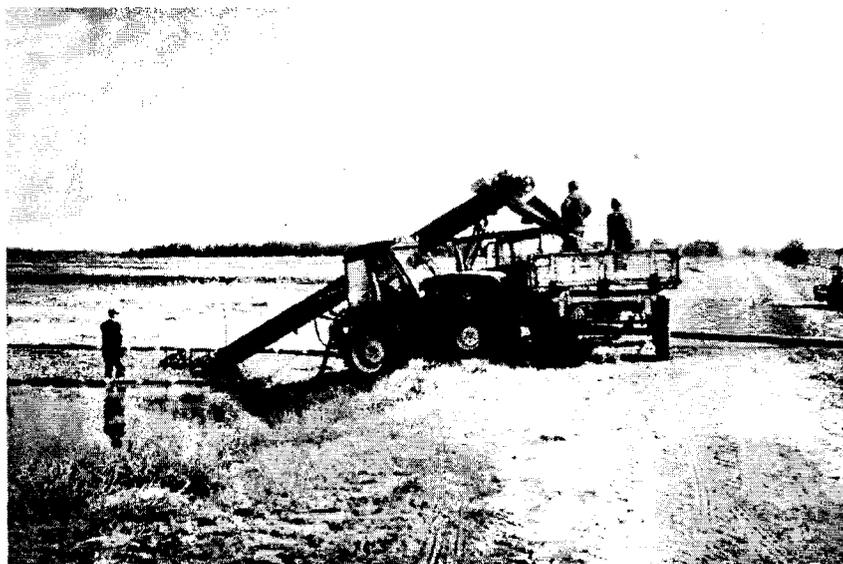
Рис. 1. Выборка ягод из воды с использованием транспортера
