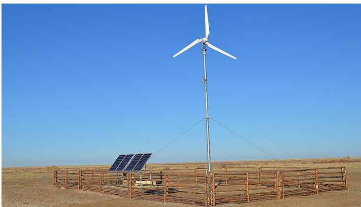
Рисунок 4 – Комбинированная автономная система электроснабжения объекта
