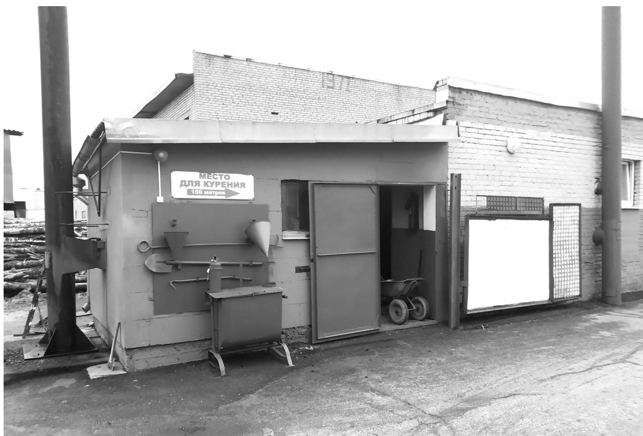
Рисунок 7.1 – Пожарный щит с первичными средствами пожаротушения
