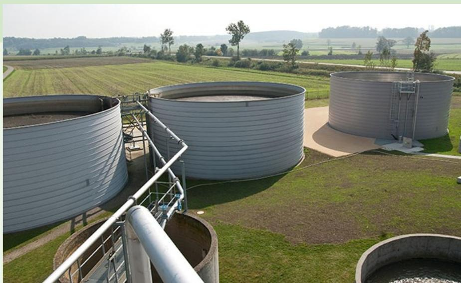
Рисунок 1. – Емкости для хранения жидкого навоза
